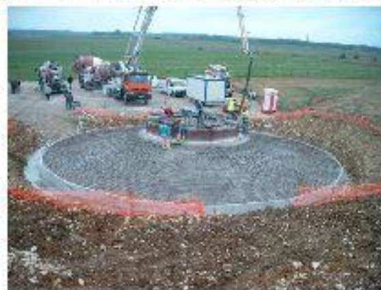
Fondation 400 m 3 de béton
